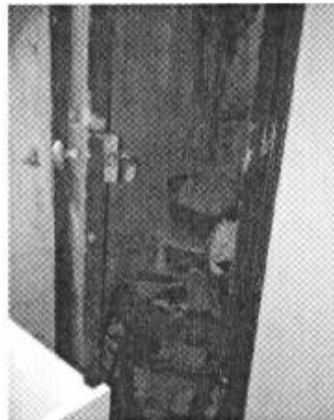
Photo 4 : Dépôt R+2 à R+3
