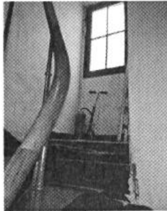
Photo 2 : Voies RDC à R-1
