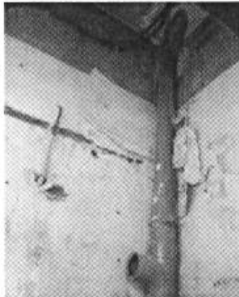
Photo 3 : Dépôt R+3 à R+4
